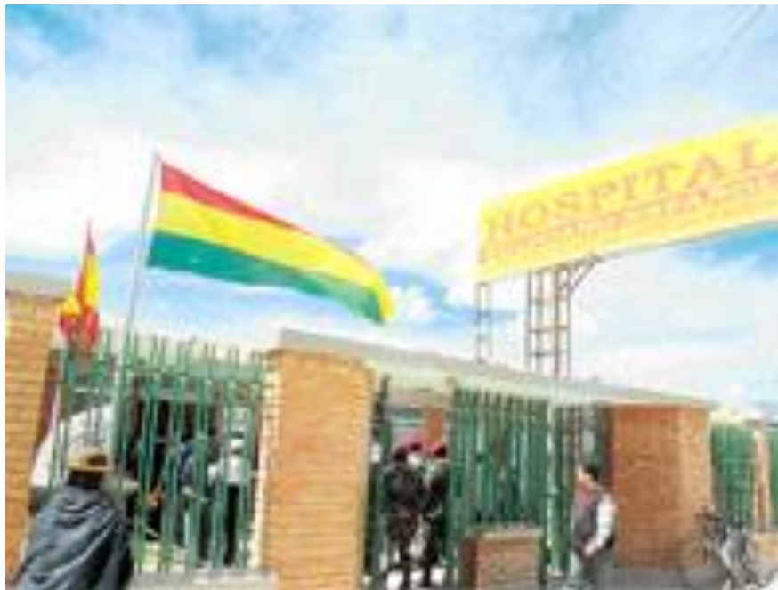
Hospital de 2do nivel de Patacamaya
