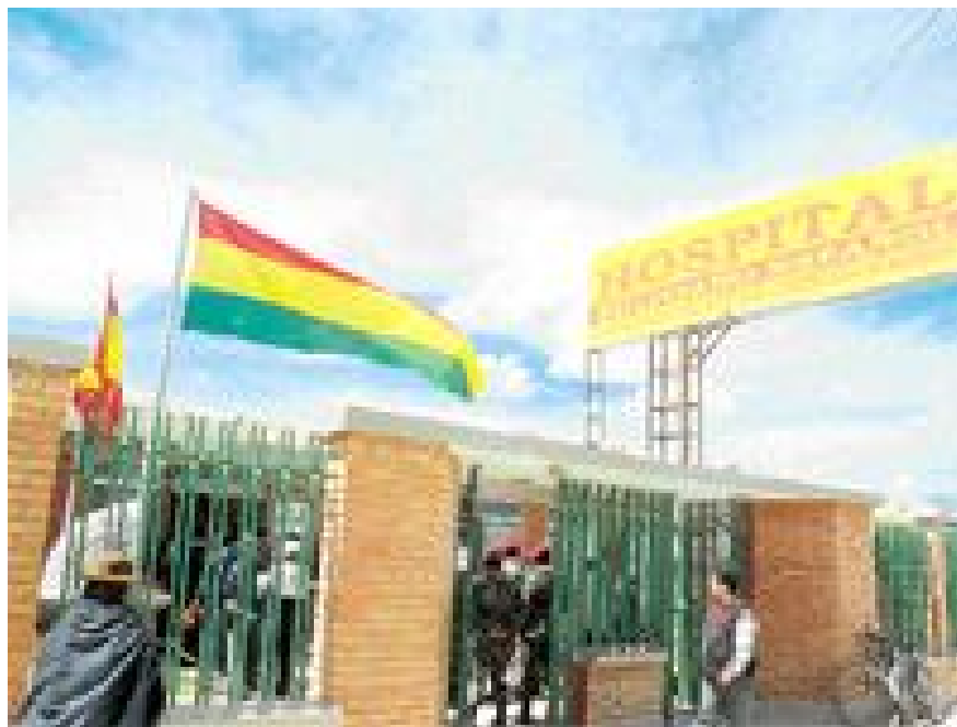
Hospital de 2do nivel de Patacamaya
